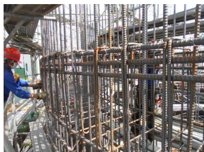
①鉄筋を組み立てます
