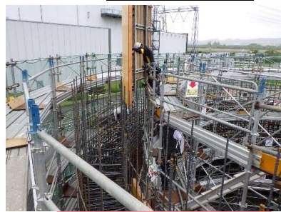
②型枠を組み立てます
