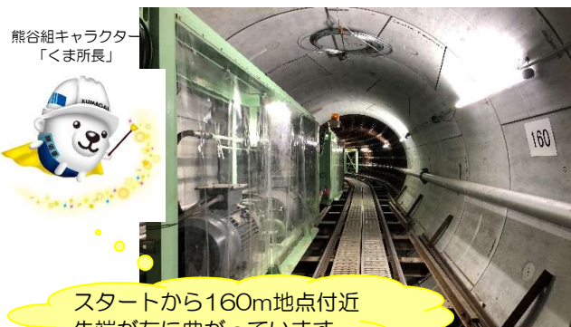
変電所正門付近地下 半径25mで曲がっています
