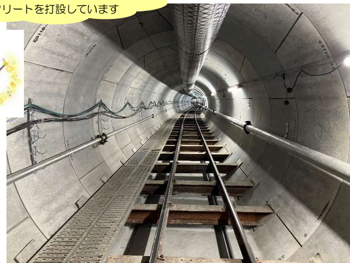
トンネル内現況
