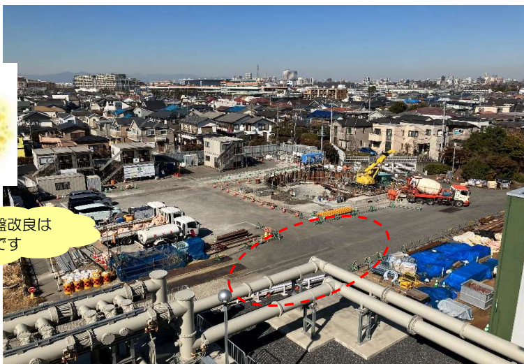
変電所構内（発進立坑） 全景
