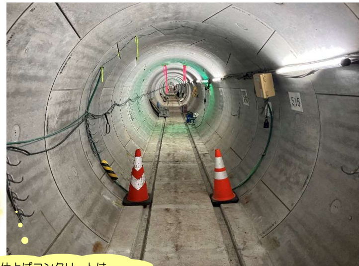
トンネル内仕上げコンクリートは 床面が打ち終わりました
