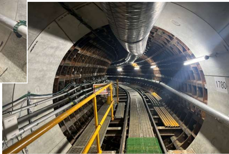
トンネル内（車返団地交差点）付近 左カーブ
