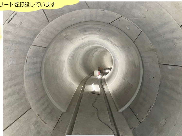
トンネル内現況
