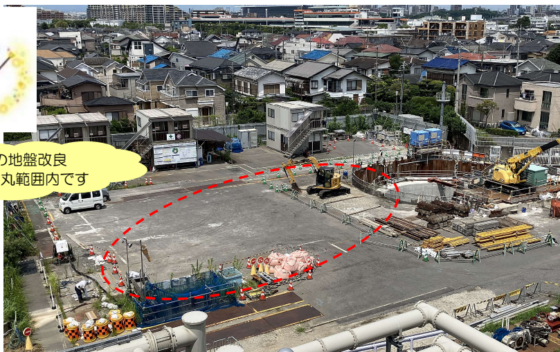
変電所構内（発進立坑） 全景
