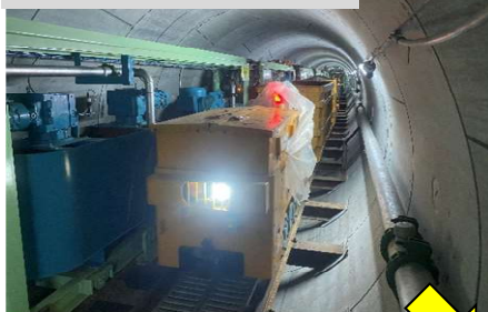
トロッコで掘った土を運搬
