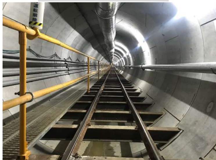
トンネル内（白糸台通り）
