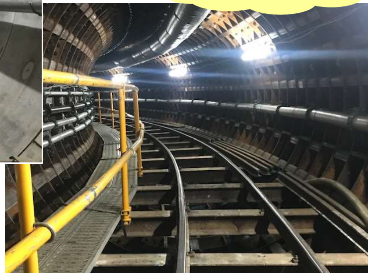
トンネル内（車返団地交差点）付近 左カーブ
