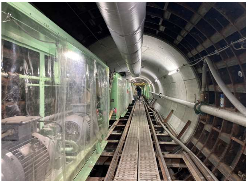
トンネル内（六中角交差点付近）
